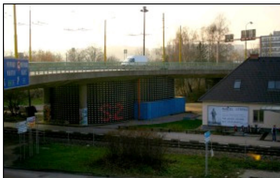
Obr. 8: Konstrukce „S2ky“ pod kruhovým objezdem v Žilině, zdroj [14]
