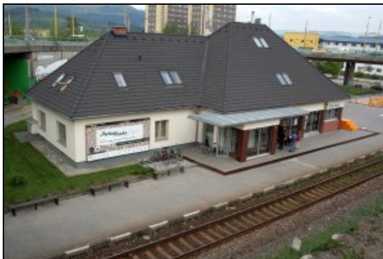
Obr. 7: Železniční stanice Žilina-Záriečie, zdroj [14]
