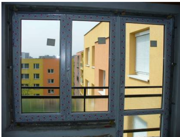
Obr. 5b: Osazení výplně na původní místo s odstoupeným rámem – ošetření připojovací spáry.
