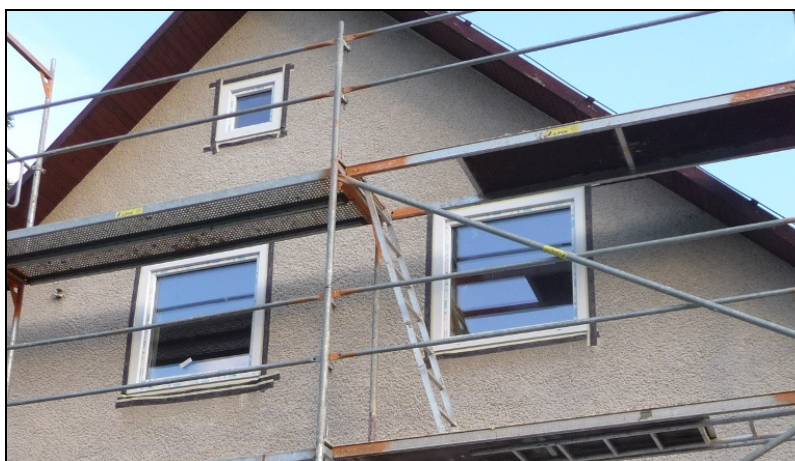
6b: Osazení výplně na vnější líc nosné konstrukce-pohled z exteriéru.
