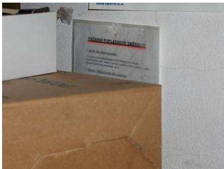
Obr. 6. 7: Nevhodně umístěné požární poplachové směrnice, foto D. Petrželka 2009.
