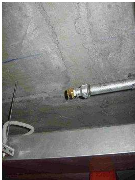
Obr. 3.2: Fotografie clonové hubice vodní clony [3].
