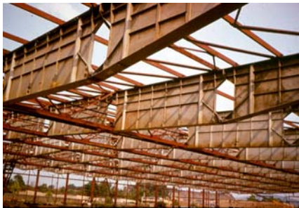
Obr. 12 Montáž zastřešení zimního stadionu v Lounech z demontovaných dílců provizoria.
