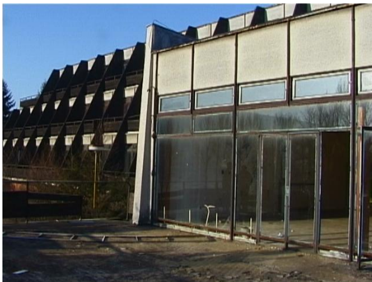
Obr.2: Vlevo hotelová část (ubytování), vpravo provozní část s terasou (jídelna, konferenční místnosti, kuchyně)
