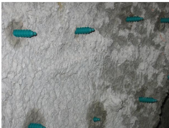
Obr.11: Pakry pro tlakovou injektáž
