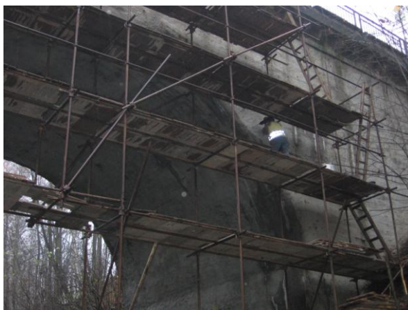
Obr.12: Lešení pro provedení injektáže
