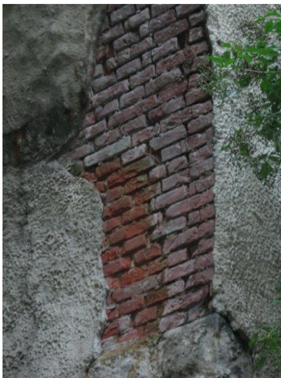
Obr.4: Detail klenby - východní strana, severní část - přechod na kamennou podpěru
