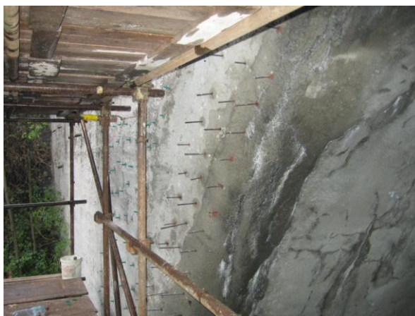
Obr.10: Armovaná injektáž klenby – připravené pruty výztuže
