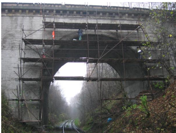
Obr.8: Celkový pohled na most při sanaci
