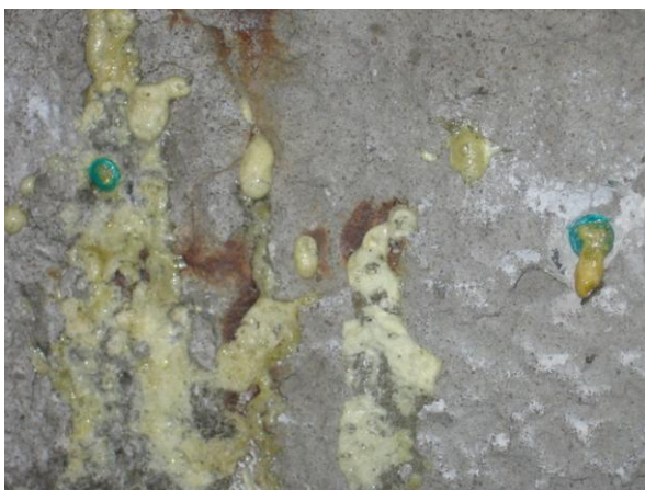
Obr. 9: Povrch po injektáži před zednickou úpravou
