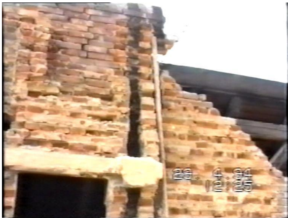
Obr.3: Komůrkové zdivo v okolí dveřního otvoru.
