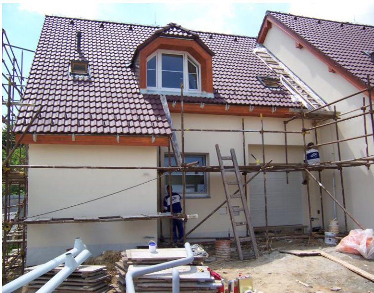
Obr.2 Výstavba řadových domů 1. etapa
