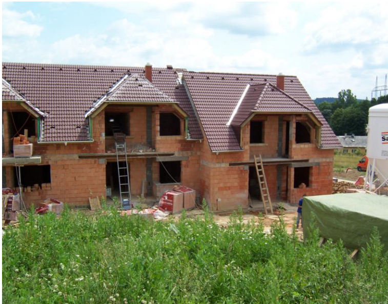
Obr.1 Výstavba řadových domů 1. etapa
