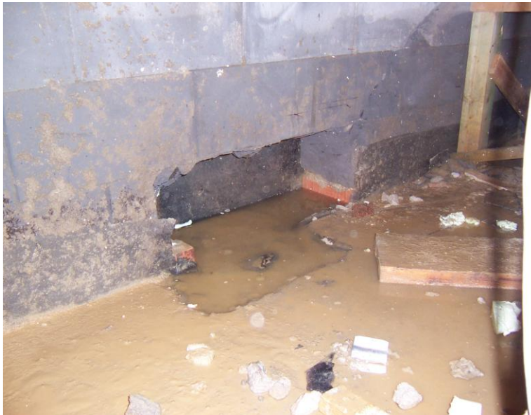
Obr.5 Sonda v plynosilikátovém zdivu
