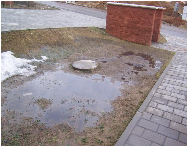
Obr.8 Násypová nepropustná zemina po dešti
